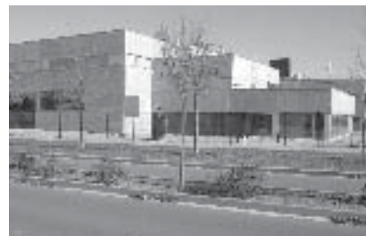
Edifici de fisioteràpia
