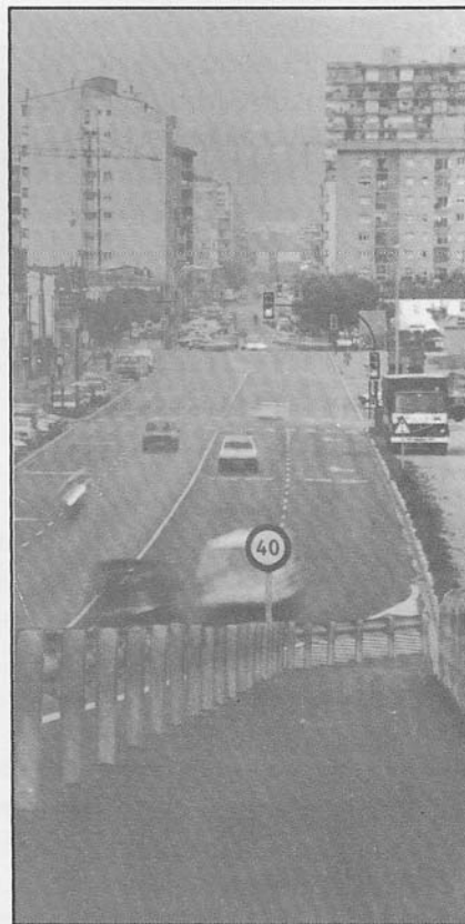
Nou Pont sobre l'autopista que enllaça amb la N-141, al pg. dels Països Catalans.
