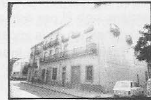
Una de les nombroses intervencions de rehabilitació d'edificis antics realitzades aquests últims anys en el barri vell de Salt: can Peixet.
