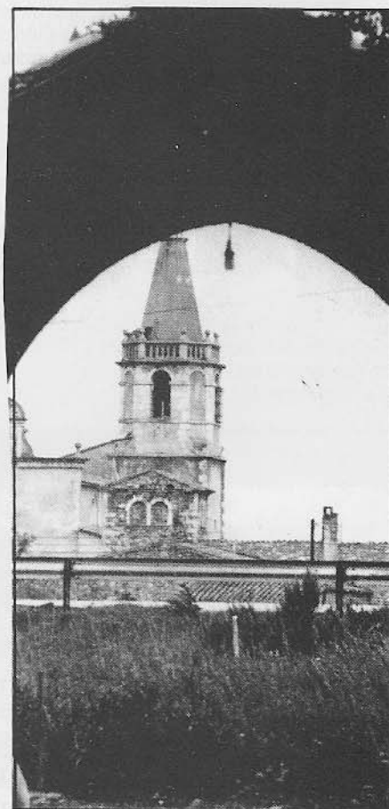
El portal d'entrada a la finca del Marquès de Camps, punt que antigament comptava amb una excel·lent perspectiva visual sobre el nucli vell de la Vila i els camps de conreu que l'envoltaven, ara aguanta estoicament, mig amagat rera un talús, el brogit del trànsit que circula per l'autopista A-17, la més arbitrària i descontextualitzada de les vies de comunicació que travessen el Pla de Salt.
