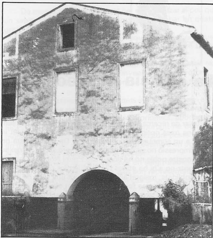
Aquest edifici, actualment sobre el llit de la Sèquia, al costat mateix de la central del Molí, és sens dubte un antic establiment industrial que aprofitava també la força de l'aigua per moure les seves màquines. Podria haver estat un molí fariner i posteriorment una farga d'aram o el «Martinet de fer claus», que ens descriuen que ja existia l'any 1544. La fotografia és feta amb el Rec llevat, ja que normalment l'aigua arriba fins al punt on arrenca l'arcada central.
